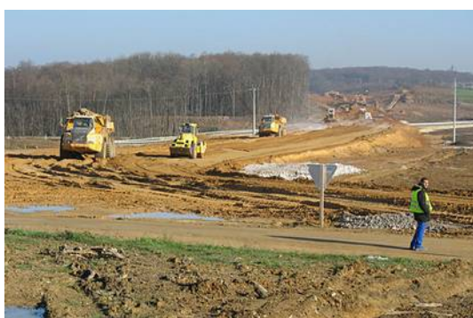
Travaux de terrassement LGV à Geneuille (25) Source : http://www.lgvrhinrhone.com/
